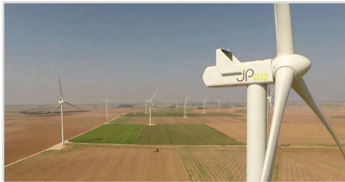
PHOTO 1 - PHOTOGRAPHIE DU PARC EOLIEN DU MOULIN D'EMANVILLE
